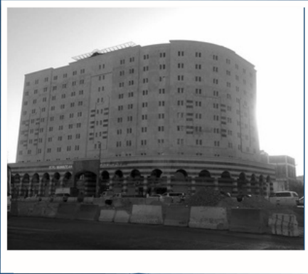
Modah Hotel Tower Almadenah برج فندق موده - المدينة
